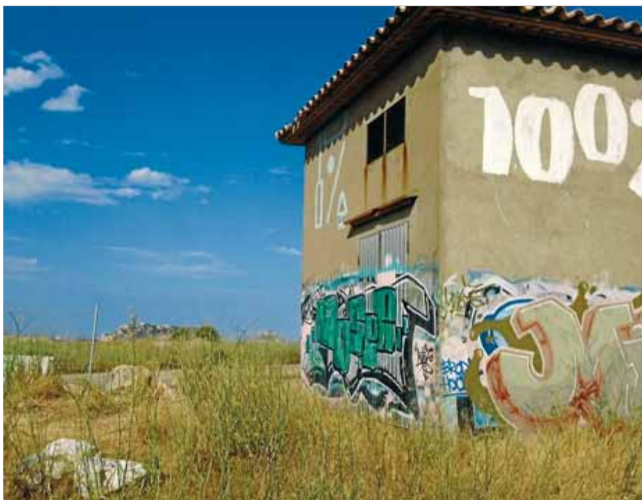
La caseta del transformador es convertirà en mirador de la zona de Ilacunes ■ J. PUNTÍ
