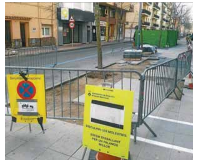
Una de les voreres de Palamós on s'està treballant aquesta setmana ■ EL PUNT AVUI
