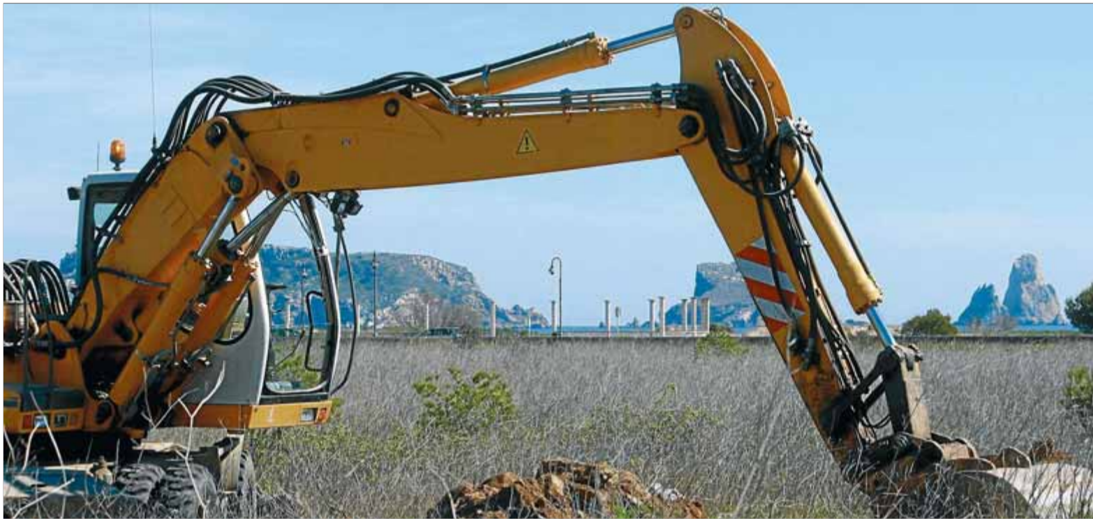
Una màquina retroexcavadora retira terra en la primera acció del pla pilot del projecte Life Pletera ■ JOAN PUNTÍ
