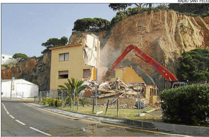
El primer edifici enderrocat va ser la seu de Protecció Civil.
