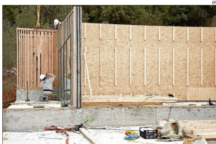
Les obres de construcció es van iniciar dijous passat.
