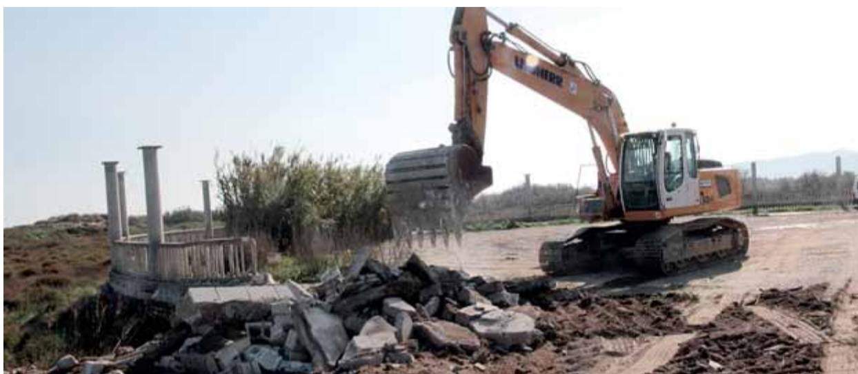
La demolició dels vials de la urbanització inacabada i desclassificada de la Pletera , en una imatge del 2015 ■ E.A.
