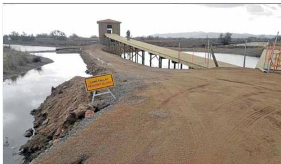
Dues imatges de l'execució de la xarxa d'itineraris de l'espai natural restaurat. DdG
