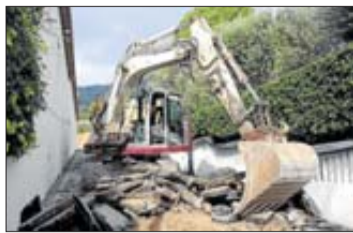
Els treballs al carrer Francesc Sabater Mécre. AJUNTAMENT DE BEGUR
